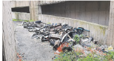
I rifiuti sparsi nella struttura
