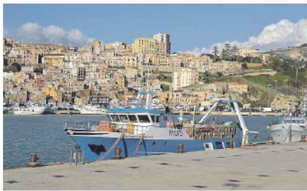
I lavori della rete fognaria sopra ed una visuale di Sciacca
